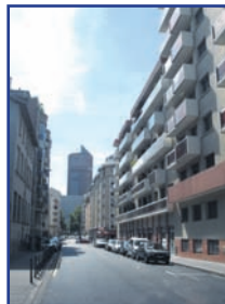
...et du béton en bas
